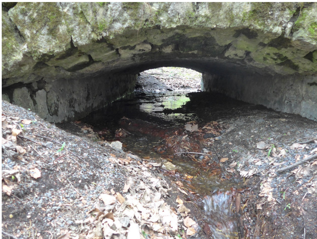
Mostek vyhovující pro migraci obojživelníků
