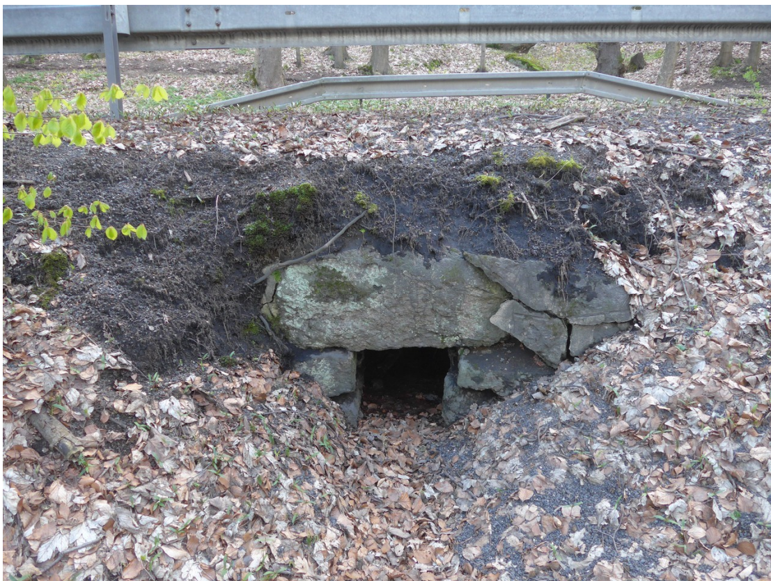
Tento propustek je i po vyčištění na hraně využitelnosti
