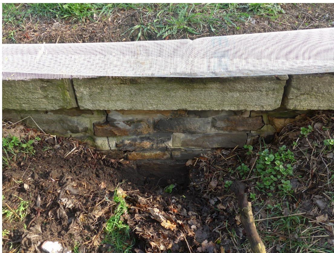
Nefunkční propustek, konec trasy L.B
